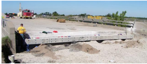
(d) Installation completed
